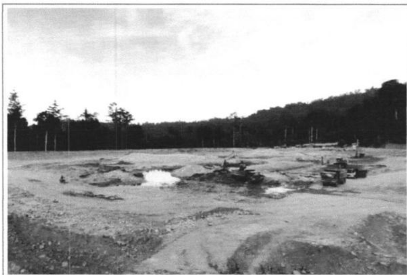
Gambar 4.5. Aktivitas Pembangunan Bendung Wanggar
